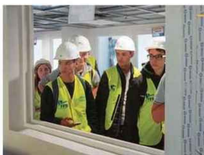
Parmi les visiteurs, les élèves de la classe de 2 de AFB (Aménagement Finition du Bâtiment) du lycée André Cuzin (Caluire-et-Cuire)
