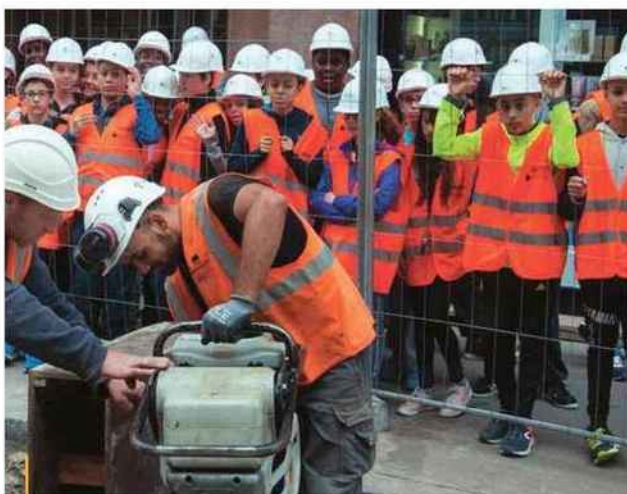
Les élèves de 4 e du collège du Tonkin de Villeurbanne sur le chantier de la ligne C3
