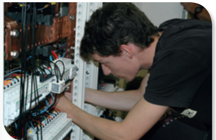
Câblage d'une armoire lors des 4 heures de module La Mache
